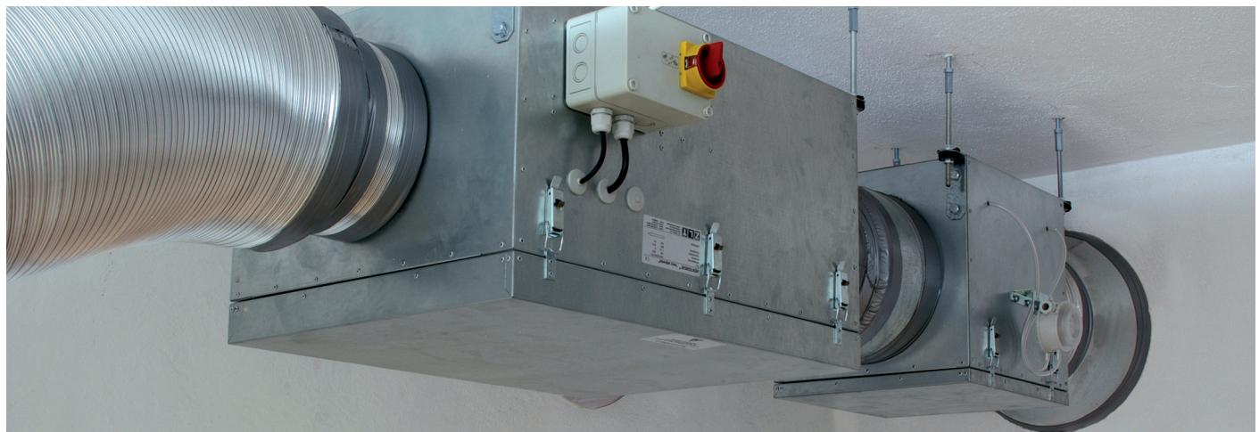
**Вентилятор для механической системы вентиляции**
